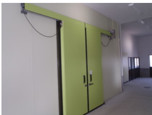
㉑両引き自動扉完了
