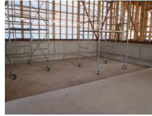
②掘込土間コンクリート
