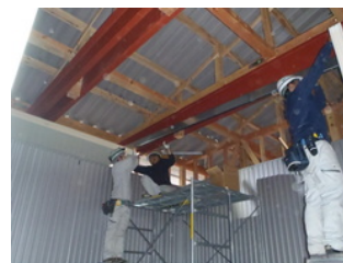
⑧天井吊り梁り取付
