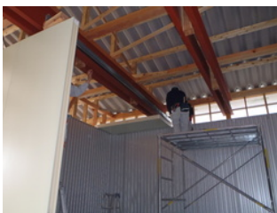
⑦天井パネル取付
