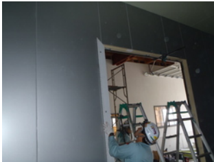
⑰両引き自動扉取付
