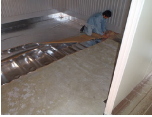
⑬ R Aシート貼り
