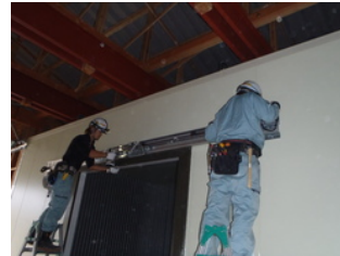
⑱自動扉吊りレール取付
