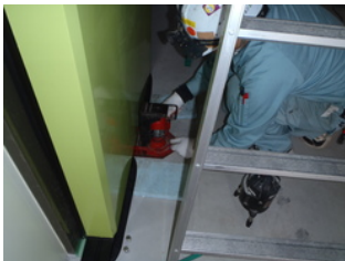
⑲大扉取付
