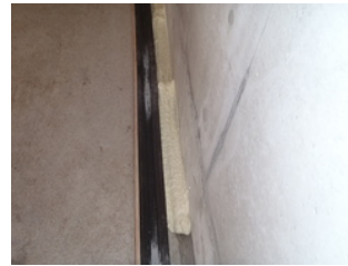
④樹脂ベース発泡注入
